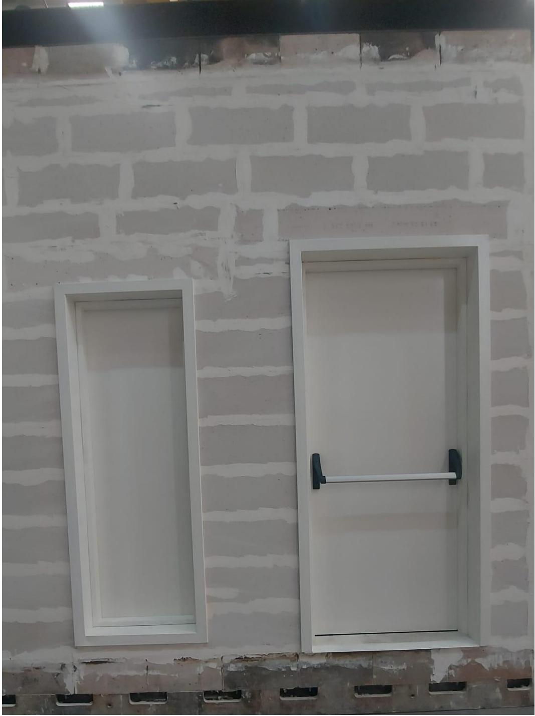
Fotoğraf C2: Test numunelerinin aleve maruz kalan yüzeyinin test öncesi görünümü
